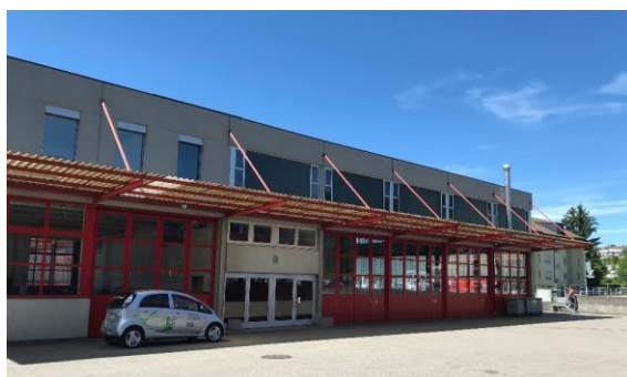
Abb. 31: leerstehende Halle (Stadt Kloten, 2020)
